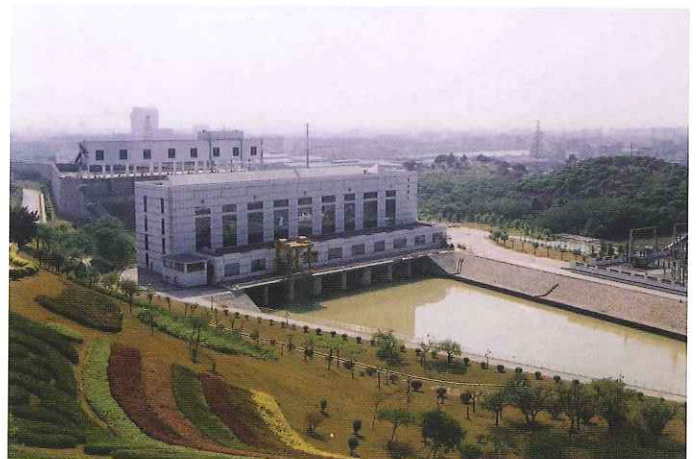
東莞供水密封式水管的地面水道
